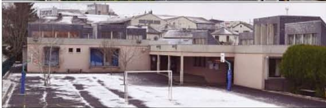
TRAVAUX. Le chantier comportera de la construction et de la réhabilitation de l'existant. DOCUMENT HBM ARCHITECTES
